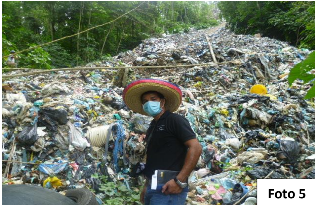
Vista desde área inferior de vertedero. (Foto antigua suministrada por el MINSA)
